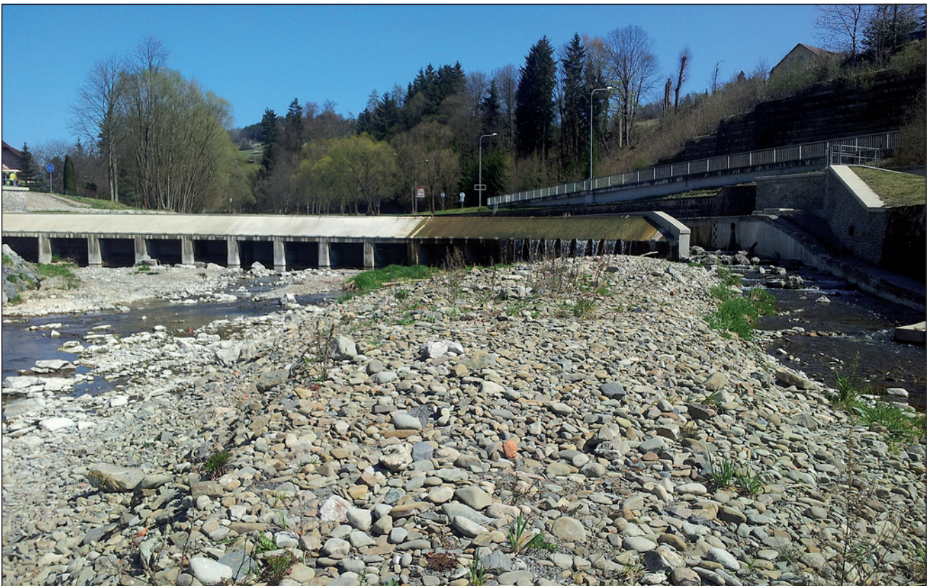
Obr. 5: Štěrková lavice na Vsetínské Bečvě vzniklá pod jezem v Halenkově. Foto: O. Konvička. Fig. 5: A gravel bar on the Vsetínská Bečva river formed below the weir in Halenkov. Photo: O. Konvička.
